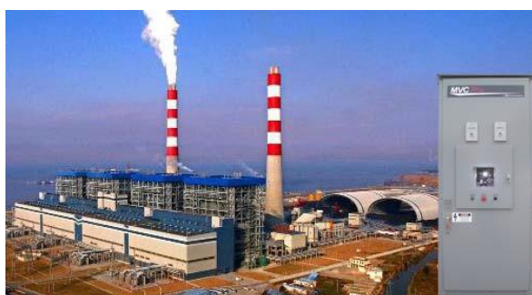
玉环电厂 4×100 万千瓦机组中的应用
